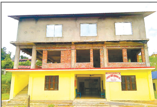
षडानन्द नपा वडा नं २ स्थित कुदाककाउले स्वास्थ्य चौकी भवन निर्माण
