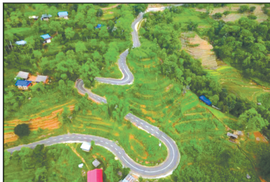
षडानन्द नगरपालिकाद्वारा दिङ्ला सतिघाट सडक पिच (पक्की) बाटो निर्माण (फोटो निदान मगर)
