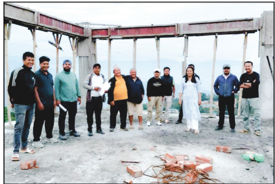
निर्माणधीन प्रशासकीय भवनको नगर उप-प्रमुख श्री प्रमिला राई ज्यू लगायत अनुगमन समितिबाट अनुगमन
