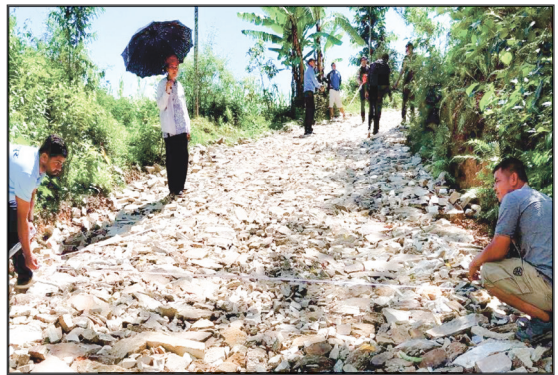
षडानन्द नगरपालिका र सडक बोर्ड साझेदारीमा सालबोटे झ्याउपोखरी सडक स्तरोन्नती
