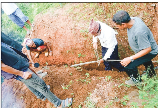
लमुखोला खानेपानी आयोजना अन्तर्गत बस्ती टोलमा वितरण पाइपलाईन जडान
