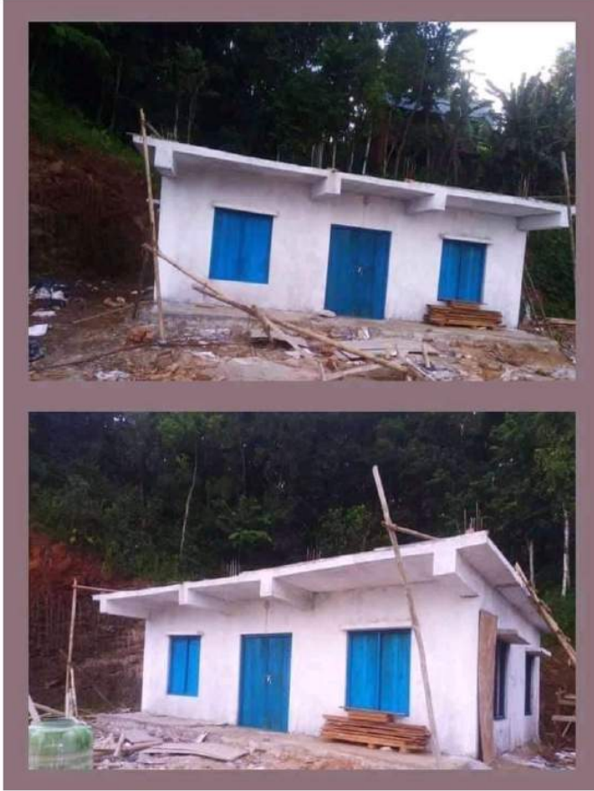
षडानन्द न.पा. वडा नं १२ को वडा कार्यालय भवन निर्माण
