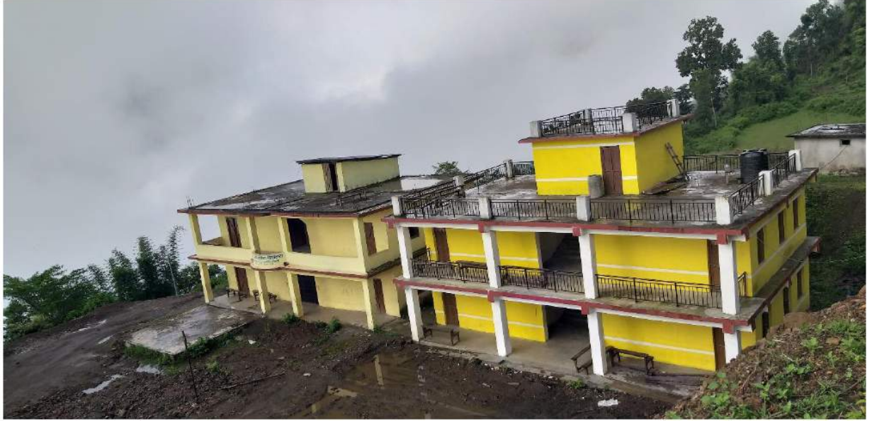
वडा नं १ स्थित नेपालेडाँडा सन्त मा.वि. को भवन निर्माण
