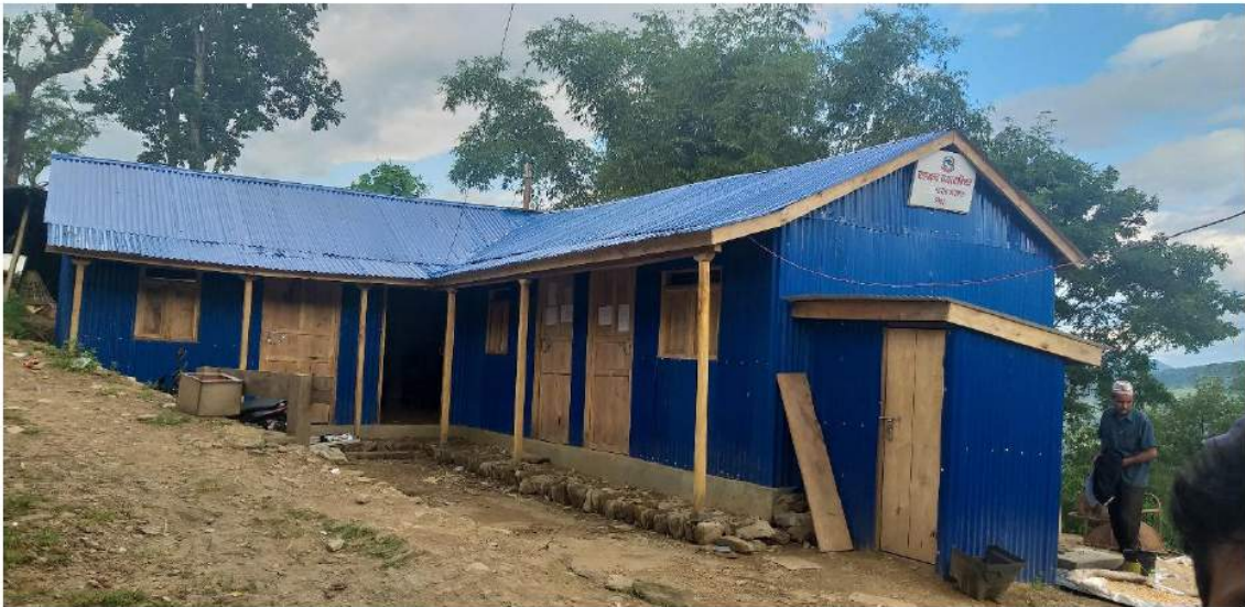
षडानन्द न.पा. वडा नं १४ को वडा कार्यालय भवन निर्माण
