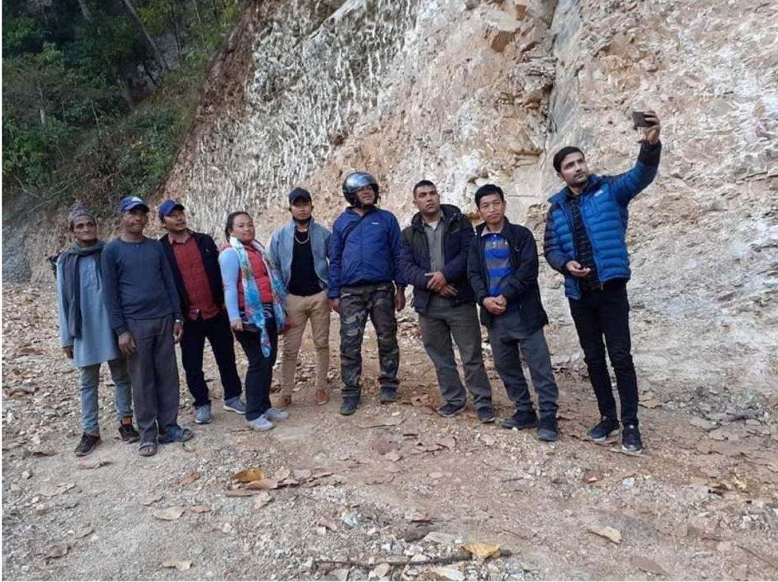
षडानन्द नगरपालिका र अरुण गाँउपालिका जोड्ने सडक निर्माणको अनुगमन
